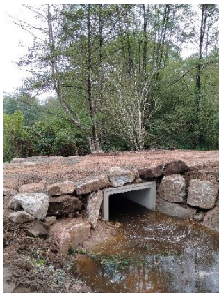
Franchissement du ru du Montmain (chemin des Maulats)
